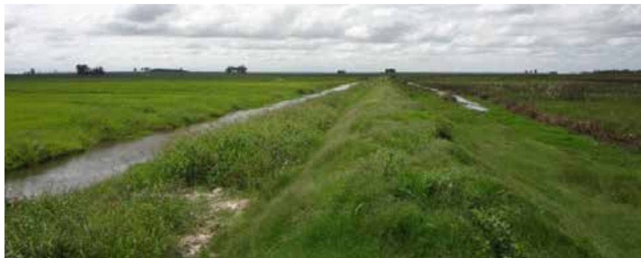
Terraplén | Fotografía: DINAGUA
