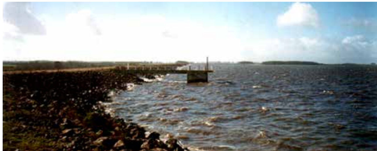
Represa del arroyo India Muerta | Fotografía: DINAGUA
