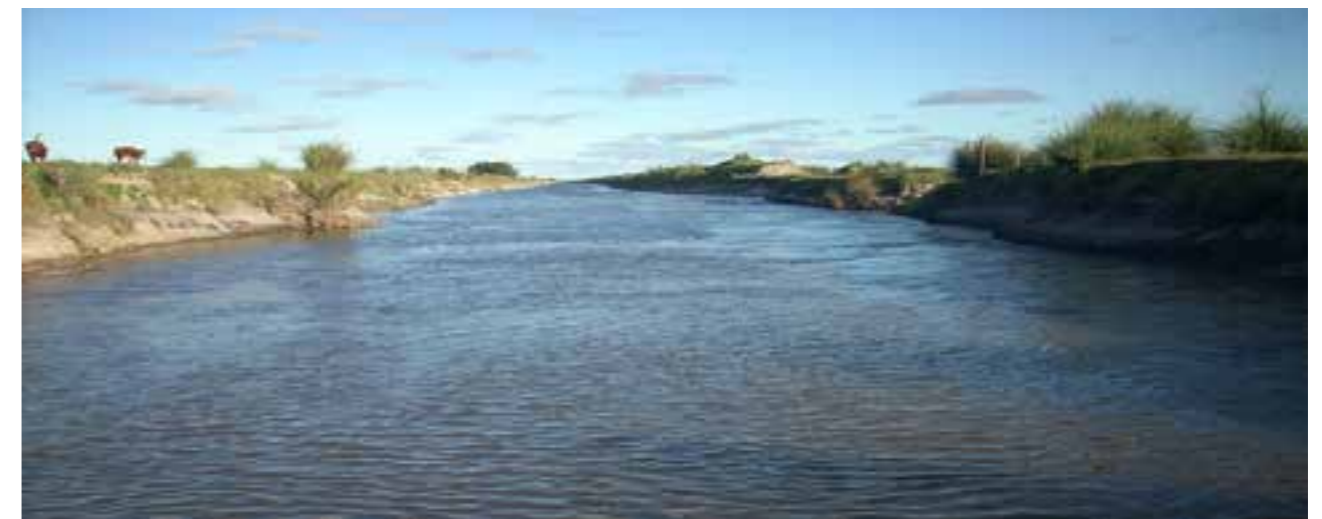
Tramo del Canal N° 1 | Fotografía: DINAGUA
